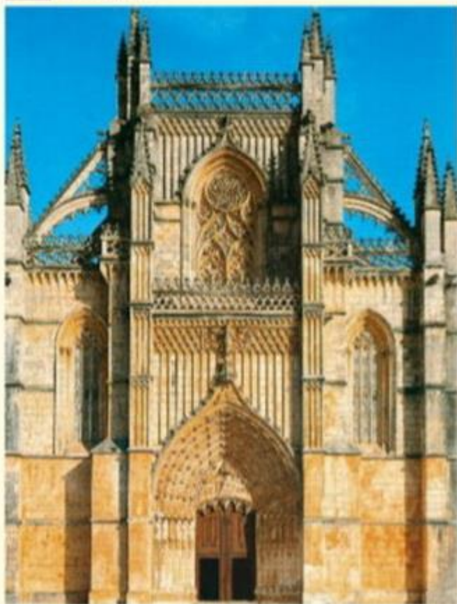
1. Fachada da igreja, obra do Mestre Huget.
