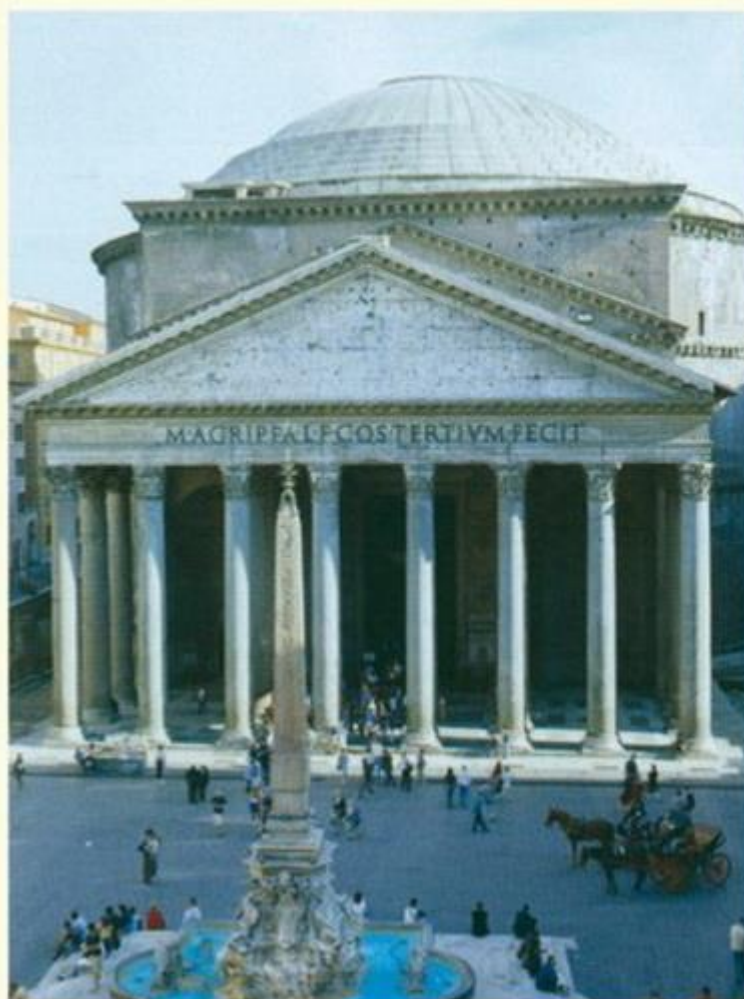
O Panteão, Roma, século II depois de Cristo. A fachada data do tempo de Augusto. Dedicado aos deuses romanos, o Panteão deve a sua grandiosidade ao corpo central circular coberto por uma cúpula com 40,3 metros de diâmetro, que inspirou os arquitetos renascentistas.
