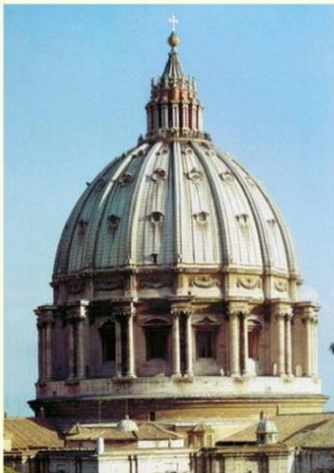
Cúpula da Catedral de São Pedro do Vaticano. Deve-se a Miguel Ângelo, que nela trabalhou entre 1547 e 1564, ano da sua morte. Tal como Brunelleschi o fizera em Florença, Miguel Ângelo projetou a cúpula de São Pedro em dois grandes cascos, um dentro do outro. Imprimiu-lhe, no entanto, uma maior verticalidade, mercê das colunas duplas no tambor alto, das nervuras e da curva elevada da cúpula. Com os seus 137 m de altura e 42,5 m de diâmetro, a cúpula de São Pedro é a maior da Cristandade.
