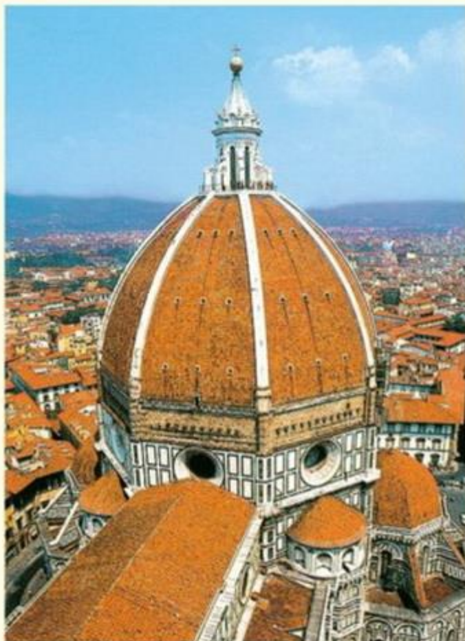
Cúpula da Catedral de Santa Maria das Flores. É considerada a primeira obra arquitetônica do Renascimento e deve-se a Filippo Brunelleschi, que nela trabalhou entre 1418 e 1436. Com os seus 114,5 m de altura e 42 m de diâmetro, domina há quase seis séculos a cidade. Brunelleschi surpreendeu pelas proporções da cúpula e pelos métodos utilizados: dois cascos em vez de um só e máquinas para içarem os materiais de construção.
