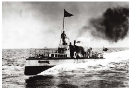
Doc. 4 – O Turbina , um dos primeiros barcos com turbinas movidas a vapor, em 1897.
