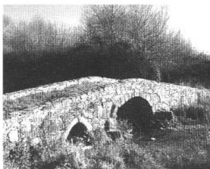
Ponte romana em Aramenha
