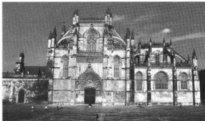
MOSTEIRO DA BATALHA
