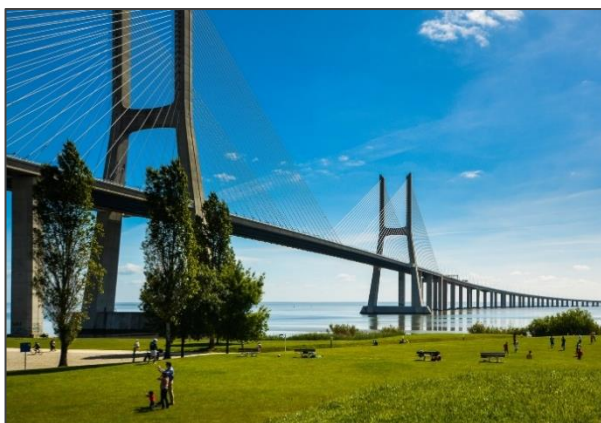
Doc. 4 Ponte Vasco da Gama (Lisboa)
