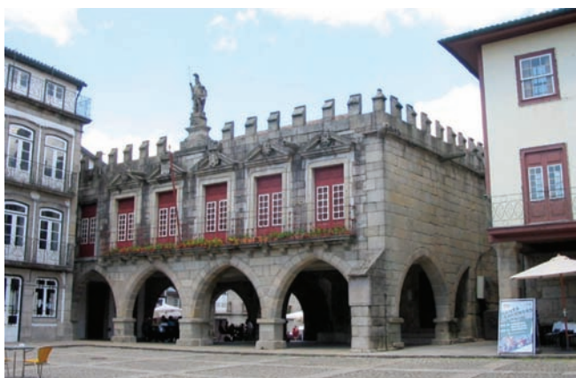
12 O granito foi, e ainda é, utilizado como material de construção.
