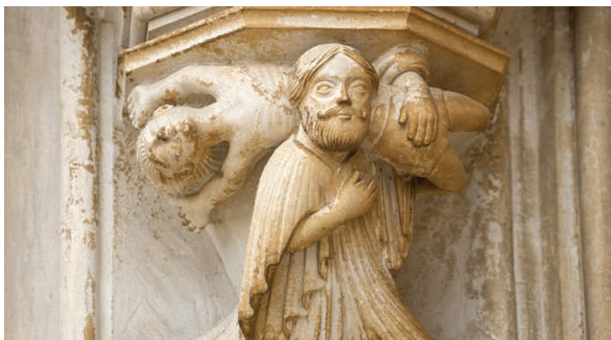
17 O Mosteiro da Batalha, construído em calcário, manifesta já efeitos da degradação desta rocha quando sujeita à ação das chuvas ácidas.
