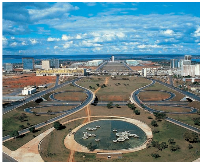
47 Brasília foi construída em 1960 com projeto do arquiteto Oscar Niemeyer. Esta cidade, a quarta em termos de população, é a atual capital do Brasil.
