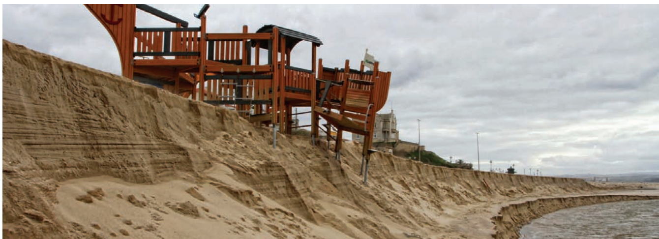
16 Erosão provocada pelo avanço do mar, na foz do Arelho, junto à Lagoa de Óbidos.
