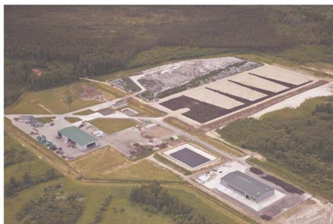
1 Vista aérea de um aterro sanitário.
