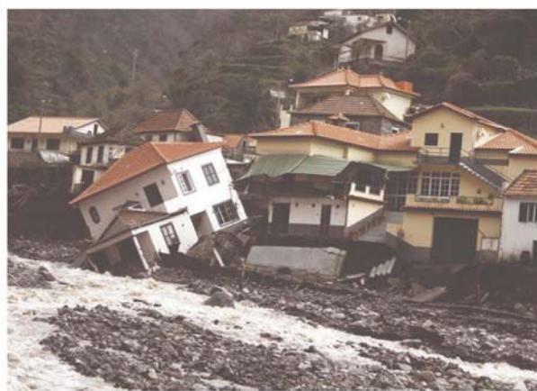
1 Habitações destruídas pela ribeira que transbordou.
