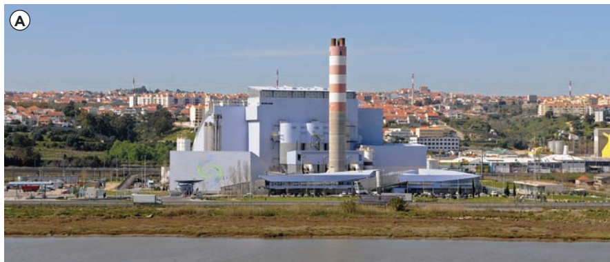
Fig. 11 Incinerador ligado a uma rede de distribuição de energia elétrica.
