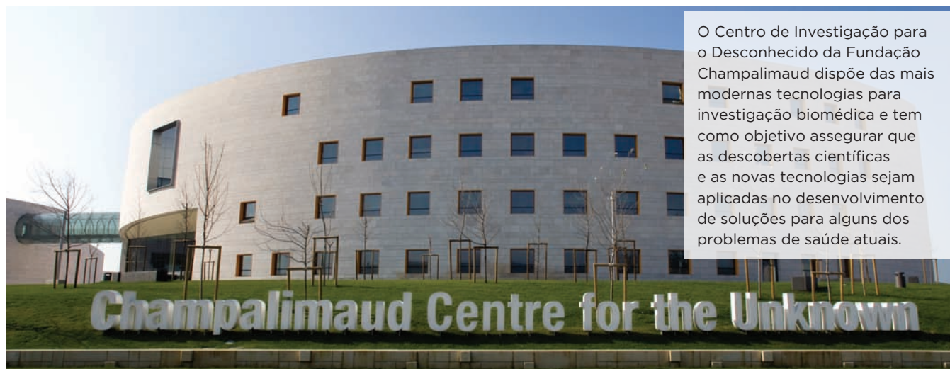
Fig. 19 Centro de Investigação para o Desconhecido da Fundação Champalimaud.
