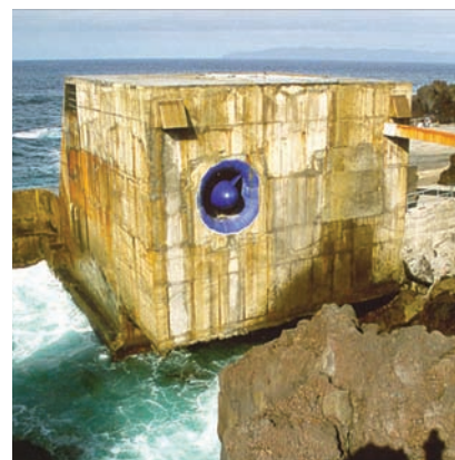
Fig. 39 A central das ondas do Pico foi um projeto-piloto na transformação da energia das ondas em eletricidade.
