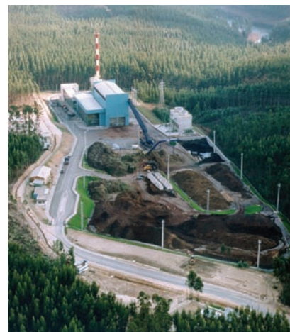
Fig. 38 A central termoeleétrica de Mortágua produz eletricidade a partir de resíduos florestais.
