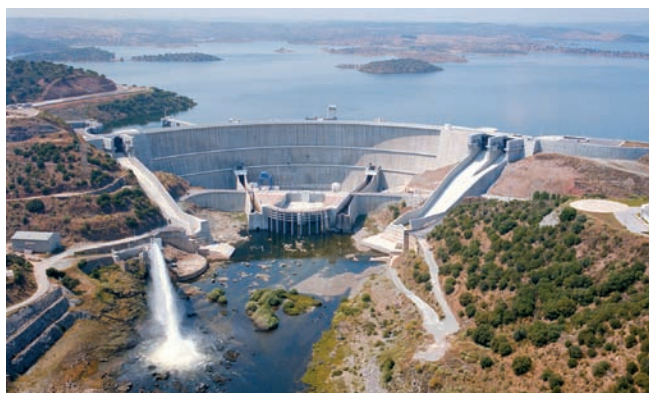
Fig. 33 A barragem de Alqueva é a maior reserva de água do País. Tem uma capacidade de produção de 260 Mw, o suficiente para fornecer o distrito de Beja.
