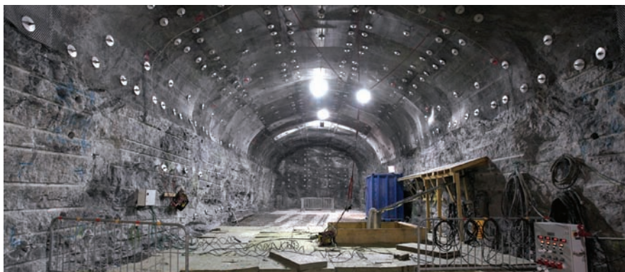
Fig. 14 Criado pela empresa finlandesa Positiva, este sistema de câmaras subterrâneas permite armazenar resíduos nucleares de forma segura durante 100 000 anos.
