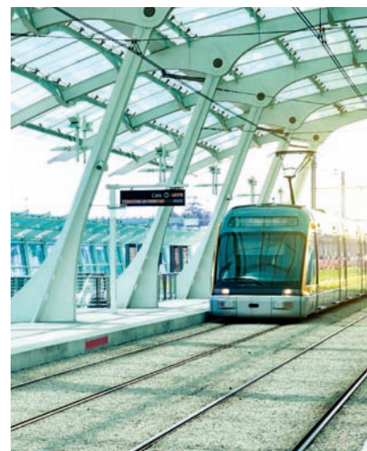
Fig. 12 Estação de metro do aeroporto do Porto.
