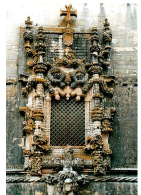
2 - Janela do Convento de Cristo, em Tomar
