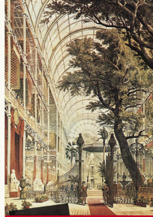
2 Palácio de Cristal, Londres, Inglaterra, construído para a Exposição Mundial de 1851. Com o crescimento das cidades surgiram grandes construções públicas como gares, mercados e estações de caminho-de-ferro, em que foram usados o ferro e o vidro. Estes materiais foram também utilizados na construção de fábricas.
