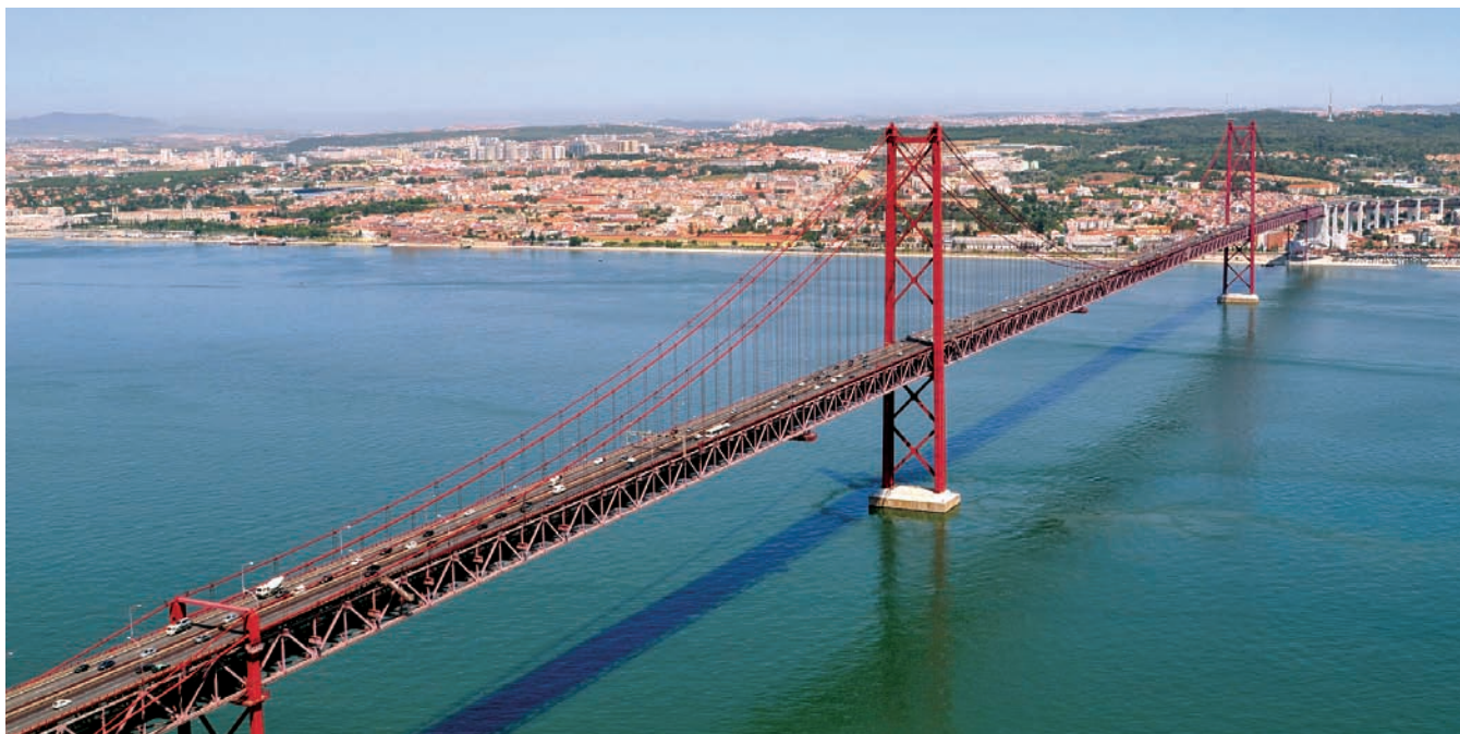
Fig. 2 Ponte 25 de Abril. Construída em ferro, que foi pintado para evitar a corrosão.
