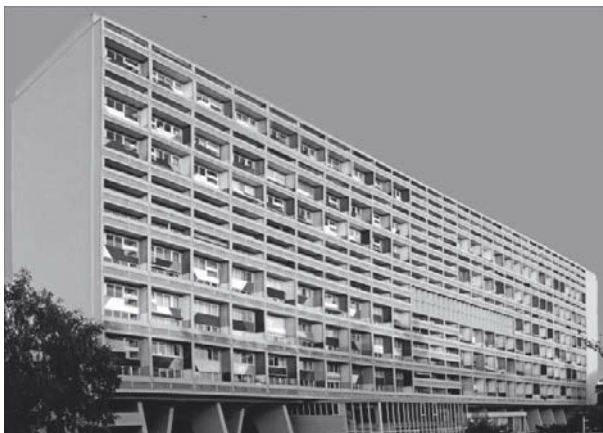
6 Prédio de habitação, de Le Corbusier, 1945-1952, França. No início do século XX, as grandes cidades tinham cada vez mais pessoas. Tornou-se, então, necessário construir prédios, com vários andares, com a função de servirem de residência a muitas pessoas. Esta arquitetura, em que predominam as linhas retas, chama-se arquitetura funcional.
